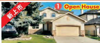
新上市 ① Open House 西北 Valley Ridge 獨立兩層屋
