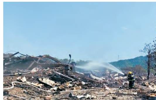
为防止救援过程中发生二次事故 救援队员在事发厂区周边设置隔离带 防火带 采取喷淋 加湿等措施 消除隐患
